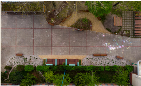
↑ Widok na błękitno-zielone rozwiązania zastosowane wokół szkoły | fot. Tomasz Kaczor
