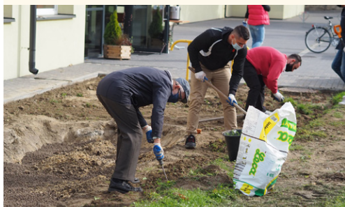
↓ Budowa ogrodu deszczowego przy szkole | fot. Judyta Łuczyńska
